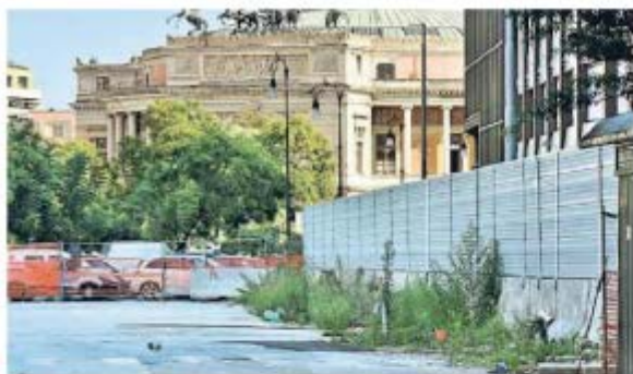
Piazza Castelnuovo, cantiere dell'anello ferroviario
