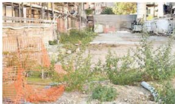
Vicolo Bernava, cantiere del passante ferroviario
