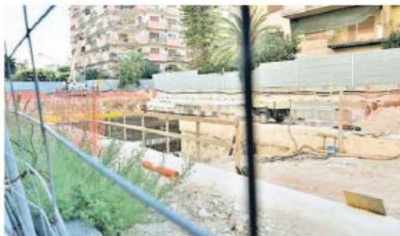
Via Sicilia, cantiere dell'anello ferroviario
