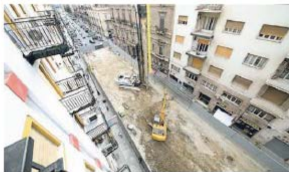
Via Emerico Amari, cantiere dell'anello ferroviario
